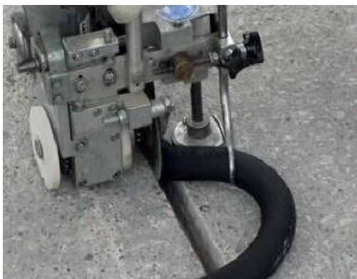
Fig.130 Plotësimi i fugave dilatacive të rrugët dhe binarët hekurodhore
