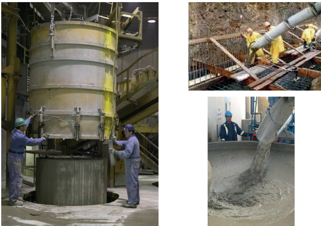
Fig. 64 Betoni i pllakës, tubit dhe elemente të tjera
