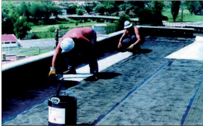
Fig 98 Hidroizolim i çatisë së rrafshët
