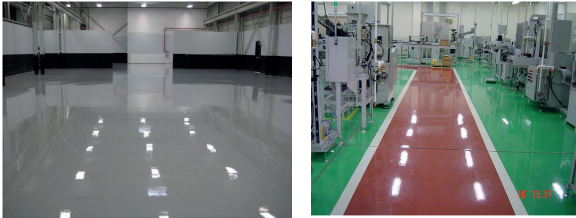
Fig.117 Dysheme epokside industriale
