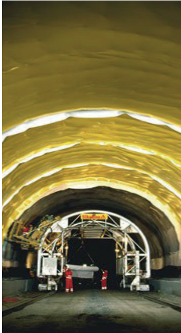
Fig. 97 Hidroizolim i tunelit
