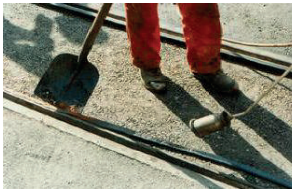
Fig.130 Plotësimi i fugave dilatacive të rrugët dhe binarët hekurodhore
