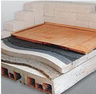
Fig.99 Shtresë e dysHEMEVE me stirodur – c
