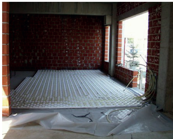
Fig.100 Izolim termik i kulmit dhe të pllakës
