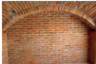
Fig. 41 Mur prej tullës së plotë për fasadë
