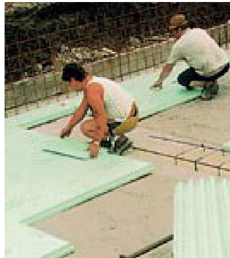
Fig.99 Shtresë e dysHEMEVE me stirodur – c
